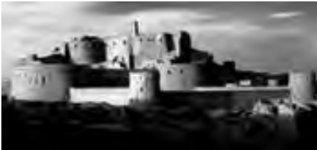
ارگ بم بزرگ‌ترین ارگ خشتی جهان است که در ساختن آن از ساروج آهکی استفاده شده است.
