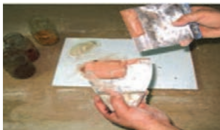
شکل ۴۶- ساخت بتونه هم‌رنگی
