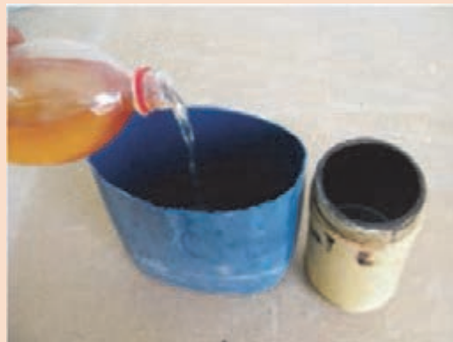
شکل ۷- رقیق کردن آستری قیری با بنزین
