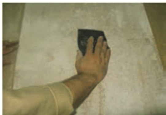
شکل ۸۰- سنباده کاری روی سطح بتونه سریشی
