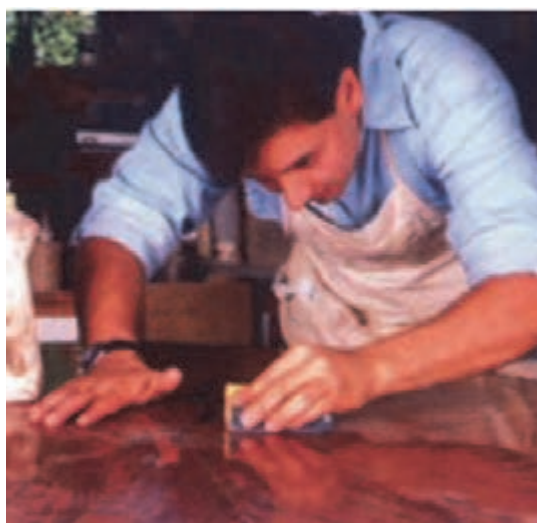
شکل ۴۶- سنباده کاری سطح پلی‌استر خورده
