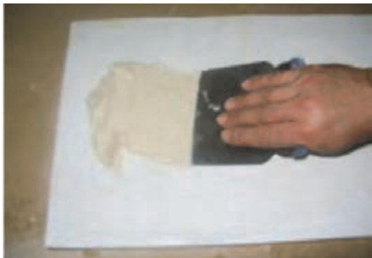
شکل ۹۱- ساخت بتونه سریشی
